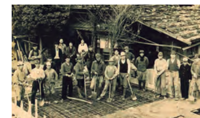
鉄筋コンクリート第一号工事(S25)
